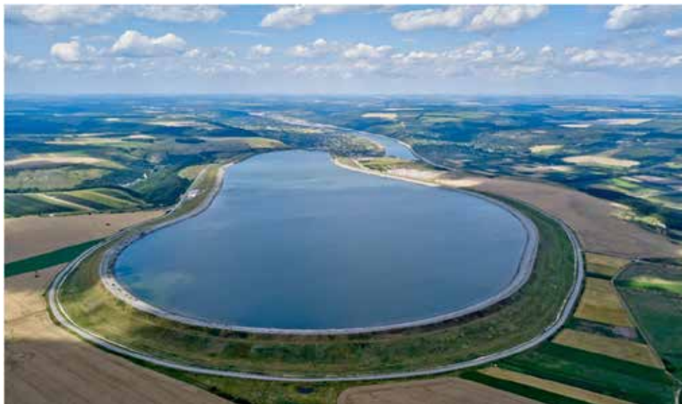
Рис. 3. Вигляд на верхню водойму Дністровської ГАЕС (ПрАТ..., 2023)
